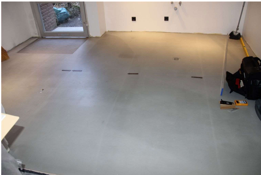
Bild 1: Deutliche Abgrenzung der Abdeckbahnen aus Tetra-Pack
